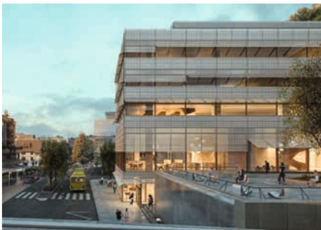
Die Basisgeschosse entfallen, eine Fassade aus Streckmetall und eine Aufwertung hin zur Äulestrasse. Fischer Architekten aus Zürich holen damit Rang 2.
