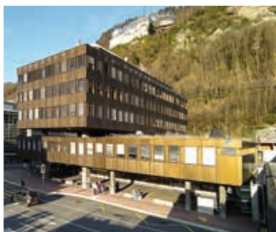
Das Bestandsgebäude aus den 1970er-Jahren mit den Basisgeschossen von der Äulestrasse aus gesehen.
